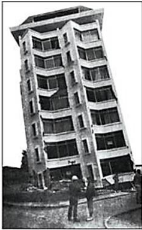
Alta excentricidad en planta. Edificio colapsó en el terremoto de Viña del Mar, Chile, 1985.
