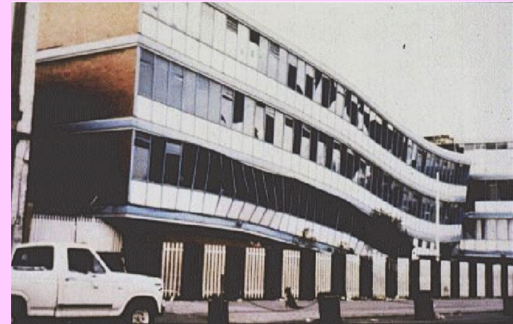
Falla de construcción asociada con el movimiento de torsión, (Ciudad de México 2007)
