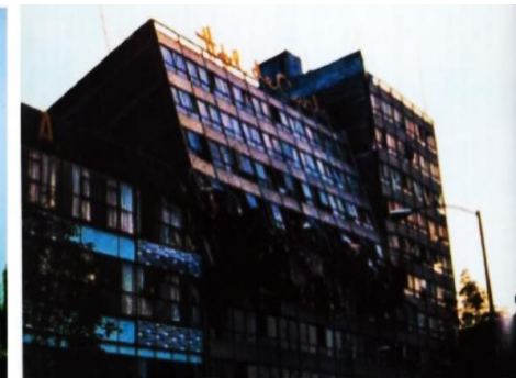
Falla debida al golpeteo entre edificios adyacentes, cuyos entrepisos no coincidían en altura.
