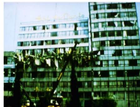
Falla debida al golpeteo entre edificios adyacentes, cuyos entrepisos no coincidían en altura.
