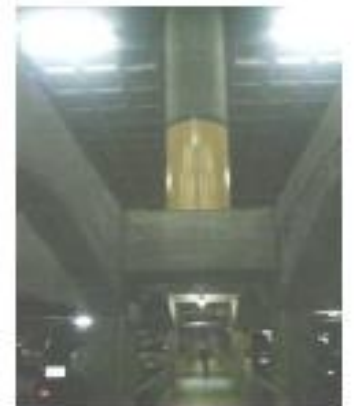
Figura 4.15. Discontinuidad en el eje de las columnas.
