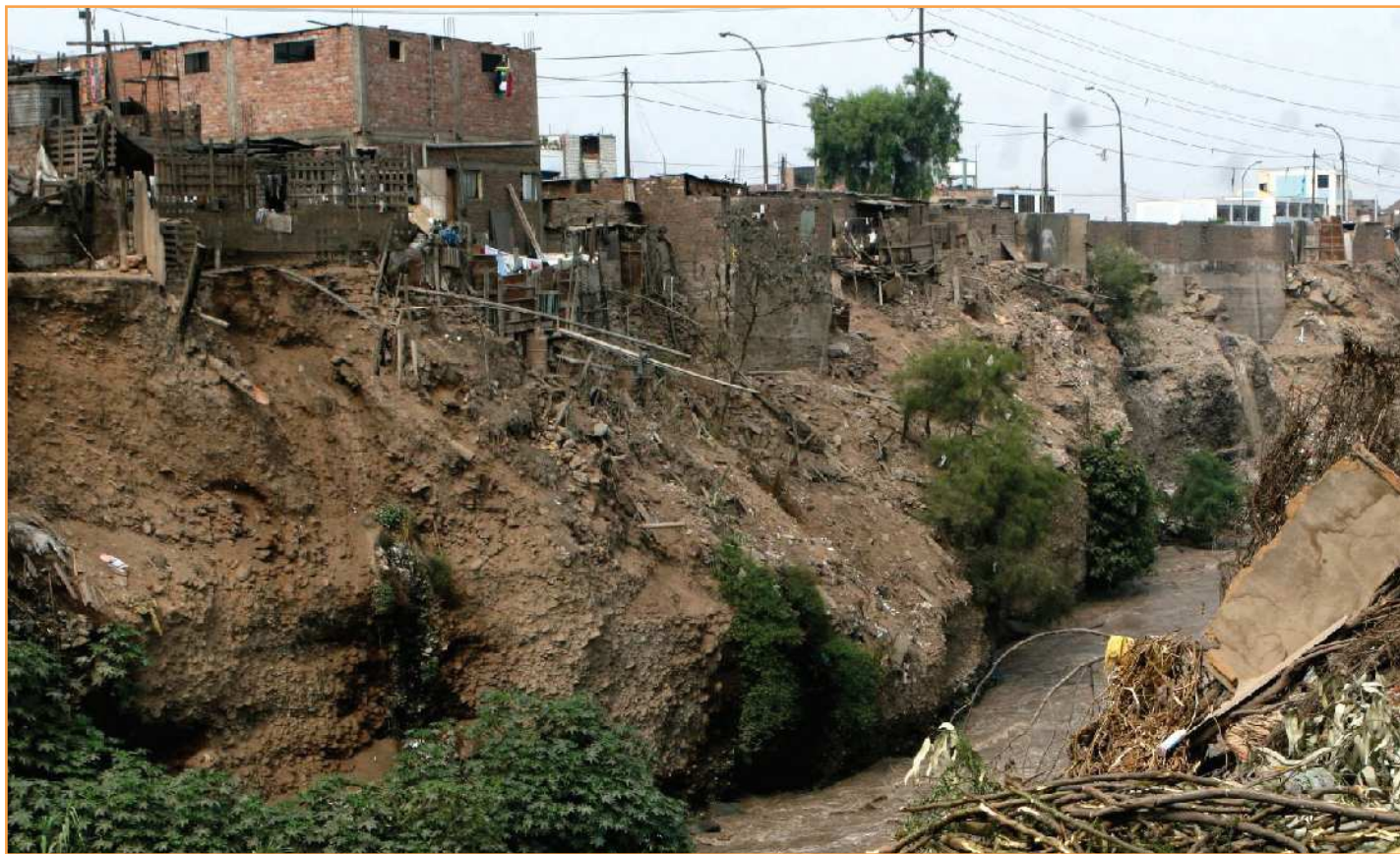
Construcciones en lugares vulnerables. Riesgo inminente..
